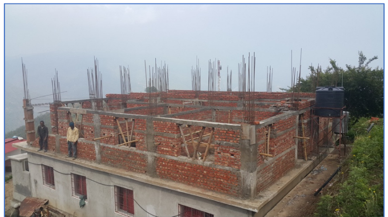
Die Bauarbeiten am 1. Stockwerk der Poliklinik haben bereits begonnen. Vor Beginn des Monsuns soll das Betondach geschüttet werden.
